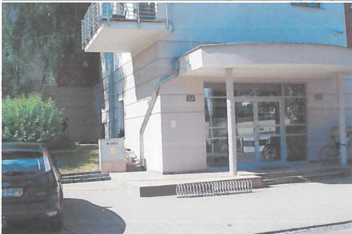
Fot. 1. Miejsce wykonania odkrytki
