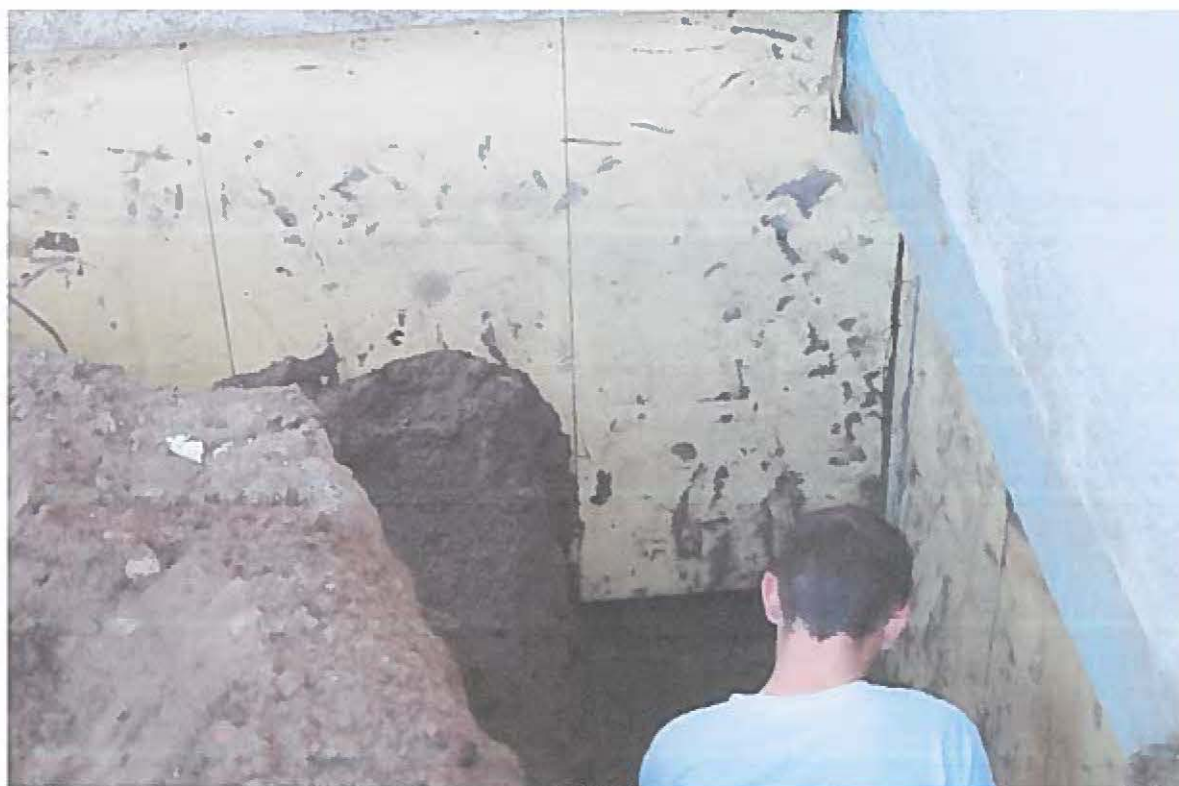
Fot. 2. Zasięg izolacji termicznej
