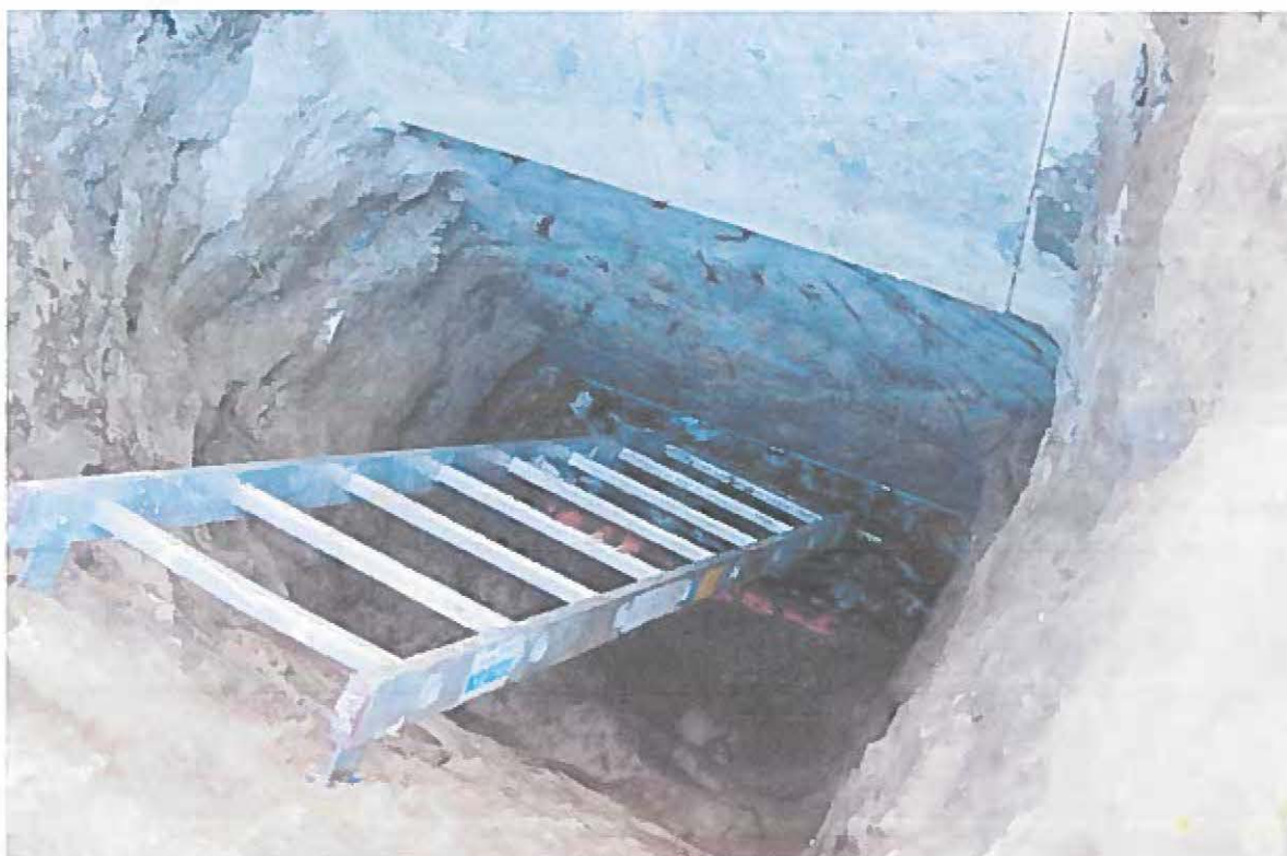
Fot. 2. Zasięg izolacji termicznej
