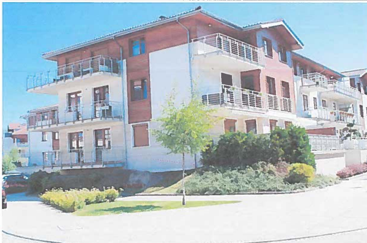
Fot. 1. Miejsce wykonania odkrywki
